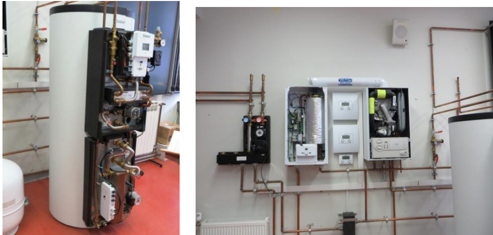
Slika 3.24. Solarni spremnik (lijevo) i regulator ili solarna Dif. automatika (desno)
