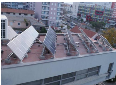
Slika 3.16. Umreženi fotonaponski sustav Srednje škole Vice Vlatkovića, iznad zbornice
