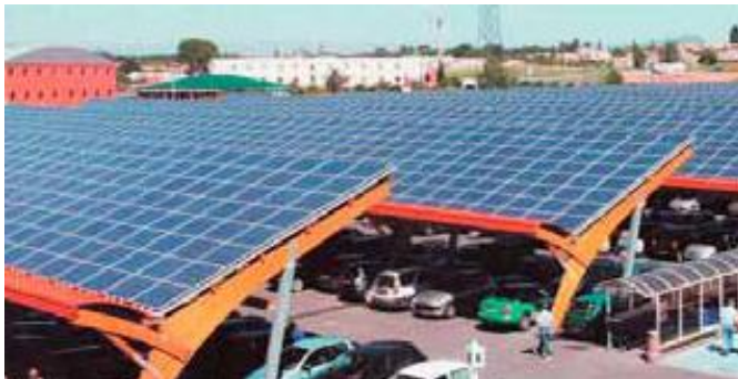
Slika 8.2. FN sustavi kao nadstrešnice parkirališta
