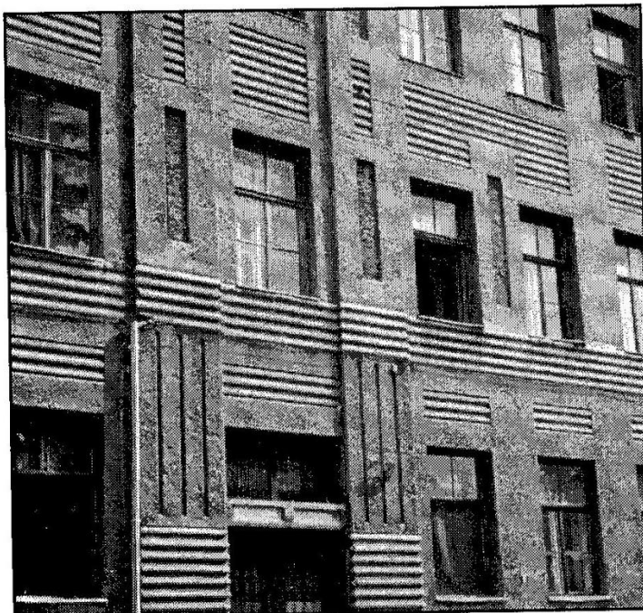
Detalj horizontalno strigilirane fasade s pilastrima
